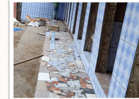
Bagni scuola in ristrutturazione
